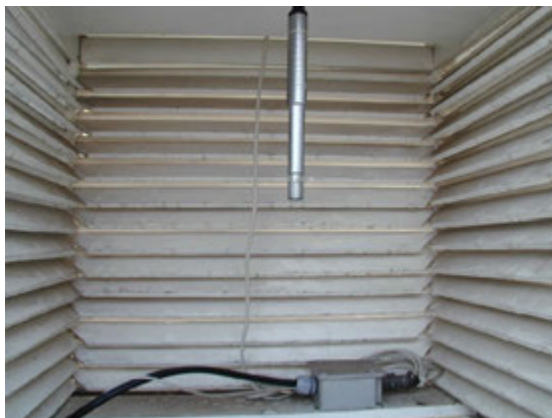
7.7. ábra: VAISALA típusú ellenállás hőmérő hőmérőházban elhelyezve
