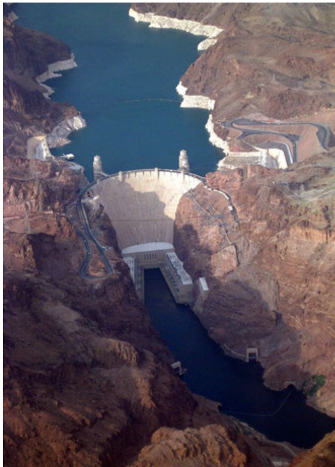
5.6. ábra: Az amerikai Hoover-gát. Beépített kapacitása: 2080 MW. A legtöbb termelt energia 1984-ben 10,348 TWh volt, 1940 óta a legkevesebb évi energiatermelés 2,648 TWh volt 1956-ban. Az átlagos energiatermelés 4,2 TWh/év. (Fotó: Florian.Arnd)
