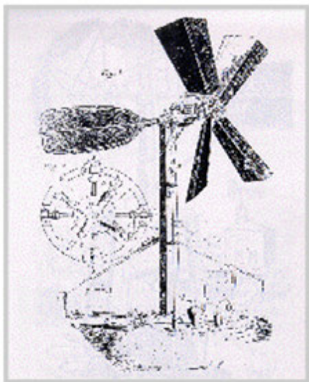
1.6. ábra: Halladay (1854) tervei alapján megépített szélmalom, mely hidraulikai elvek felhasználásával házi vízmű rendszert működtetett.
