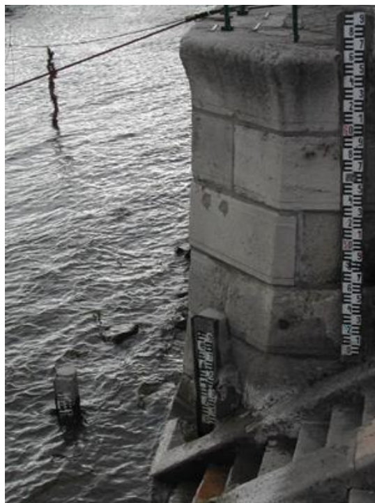
3.17. ábra. Álló vízmérce (Duna – Budapest, Nemzetközi hajóállomás)
