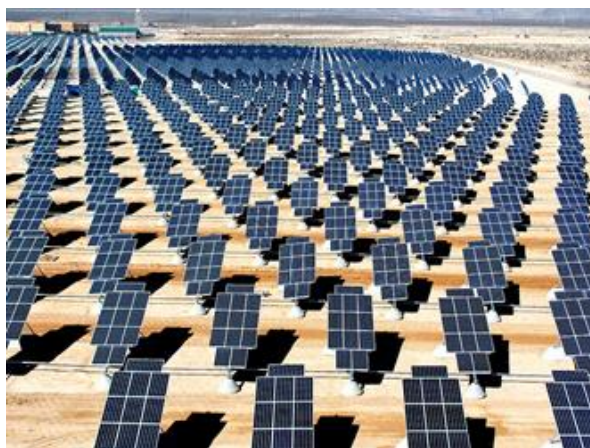
2.9. ábra. A nevadai Nellis Légierő Támaszpontra telepített fotovoltaikus napenergia hasznosító rendszer. A 140 hektárt elfoglaló 70.000 napelem közel 15 MW energia termelésére képes. (Forrás: USAF Photographic Archives)
