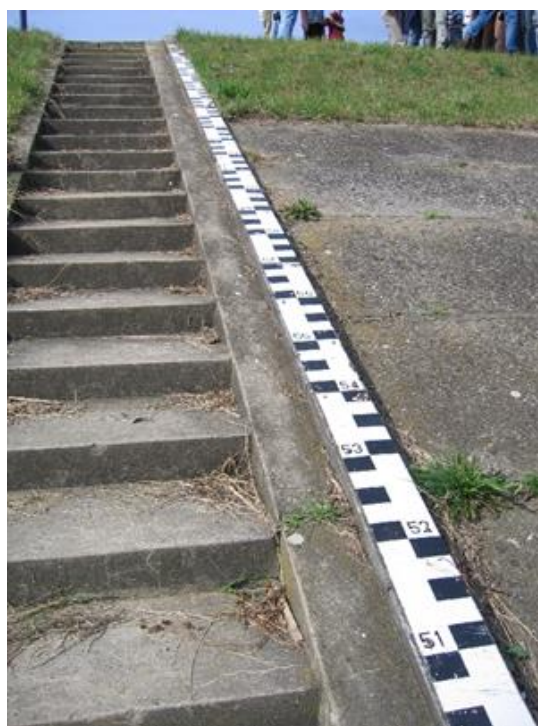
3.18. ábra. Fekvő vízmérce (a Pásztó külterületén található Hasznosi víztározó partján)
