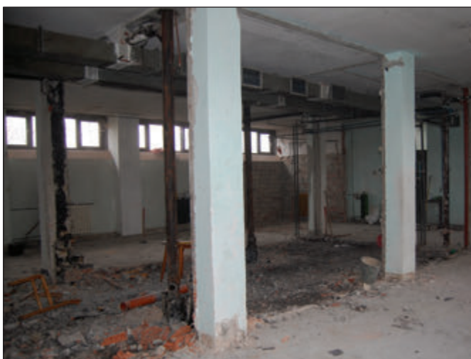
Régi öltöző a Bogdánfy úti épületben, illetve az abból kialakított tükörterem The old changing room in Bogdánfy út and the mirror room made out of it
