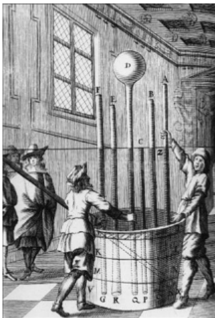
1.8. ábra: Torricelli higanykádás kísérlete, mely a barométer felfedezéséhez vezetett
